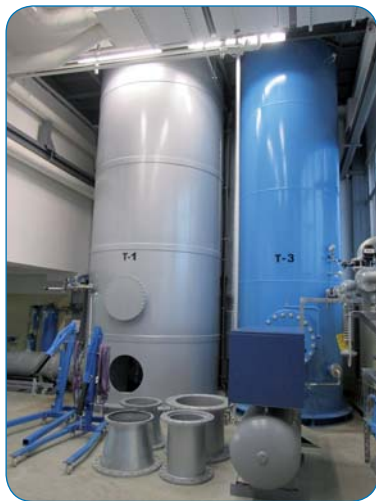
4. ábra Mérőtorony és légtartály
