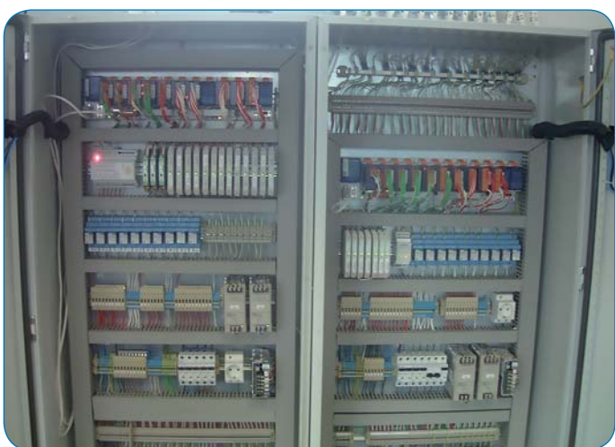
6. ábra A beépített két PCD3 vezérlőegység
